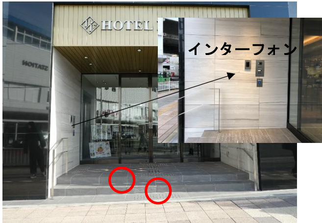
自動ドア。段差2段あり。
